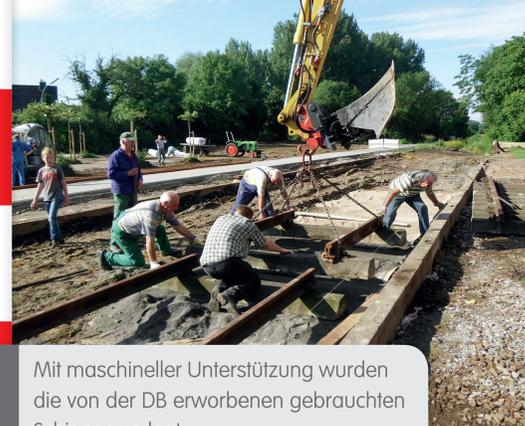
Mit maschineller Unterstützung wurden die von der DB erworbenen gebrauchten Schienen verlegt
